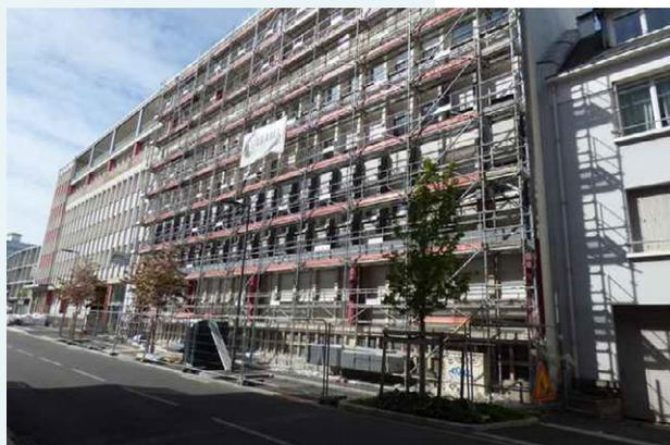
Travaux « France relance » d'isolation thermique et de remplacement de la chaudière fioul par une chaudière gaz sur le site Leo Lagrange à Clermont-Ferrand (63)
