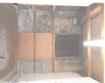
Figure 24 - Aile Nord-Ouest C - rez-de-chaussée : ancienne baie obturée suite à la construction d'un immeuble sur la parcelle voisine.
