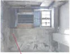
Enduit hydraulique en revêtement intérieur recouvrant une maçonnerie en moellons de granite / schiste, traces d'humidité
