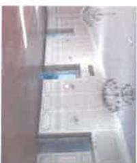
Mur à l'étage en meçonnie doté de lambbris XIXème / XXème à l'étage ; présence de nombreuses fissures au niveau des corniches
