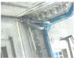
Façade Est F1 - descente EP raccordée à une descente EU à l'angle des deux pavillons sud.
