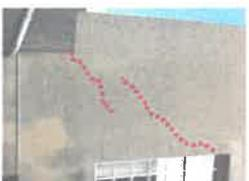
Humidité et fissuration de l'enduit et sur la façade Sud (F19)
