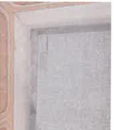
1er étage – corps de logis A : plancher bois à sous-face enduite au plâtre pourvu d'un faux-plafond isolant et présentant des traces d'infiltrations d'eau locale
