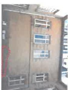
Façade Ouest : développement de mousse sur le soulèvement ; rejouissement et capillarité
