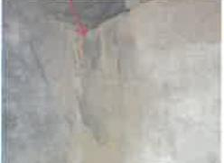
Enduit hydraulique en revêtement intérieur laissant apparaître des traces d'humidité sur la façade Nord (F11)
