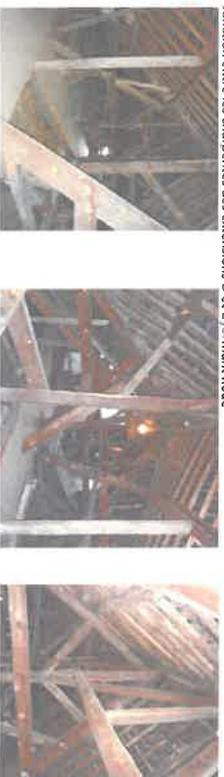
Charpente du Pavillon Sud B composée de 3 fermes, tirant subi de grosses reuses avec tirant de pièce d'assemblage reliés aux autres entités
