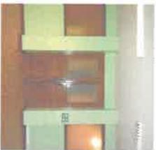
RdC, corps de logis A : sous-face du plancher avec double plâtre, poteaux coffrés de part et d'autre de la pièce
