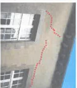
Fissuration de l'enduit sur la façade Sud (F19)
