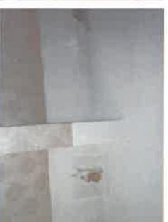
**Description :** **Mur pignon Nord aveugle en maçonnerie recouverte d'un enduit hydraulique ;** chaînes d'angle en pierre de taille de granite. Façade surmontée d'une corniche à modillon en pierre de taille calcaire.
