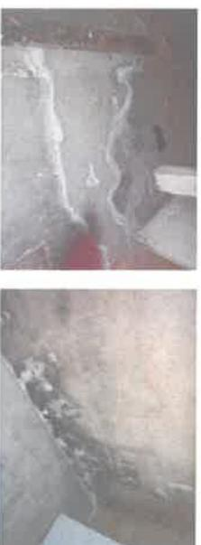
Relevement du sol du sous-sol : chape béton présentant des traces d'humidité du fait du manque de perméabilité du matériau et entraînant également des remontées capillaires sur les murs périphériques
