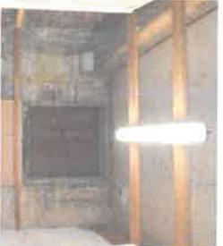
Plancher haut du rez-de-chaussée double en plâtre, poutres maîtresses apparentes reposant sur des corbeaux en granite – Allée Nord RdC
