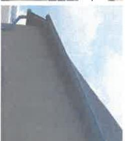
Carreaux moulurés en bois en détérioration de toit - fissures de l'enduit sur la façade Ouest (F10)
