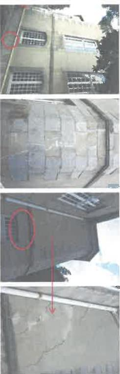
Façade Sud (F3) : traces d'humidité / ruissellement d'eau et fissures sur l'enduit de subsassement
