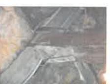
Poinçon arraché maintenu par des ergots
