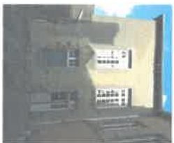
Allé Nord-Ouest - façade Sud (F9)
