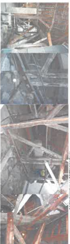
Jonction entre les charpentes des extensions D et E, portant noue
