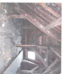
Foilage d'origine portant les fermes de la charpente de la rehausse
