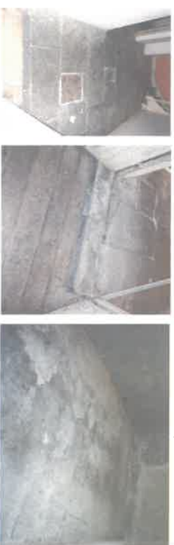
RdC, pavillon A 1 : Sous-face du plancher en dalle faux-plafond, poteau de renfort coiffé
