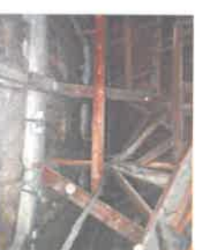
Poinçon arraché maintenu par des ergots
