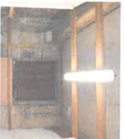
Plancher haut du rez-de-chaussée double en plâtre, poutres maîtresses apparentes reposant sur des corbeaux en granite, coffrés ou noyés dans une maçonnerie – Allée Nord RdC
