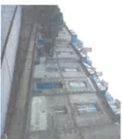
Figure 15 - Façade principale Est : façade du pavillon Sud A 1 de l'hôtel historique (F1).
