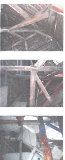
Charpente de l'extension Sud-Ouest E composée de demi-fermes reliées à la charpente de l'extension Ouest D
