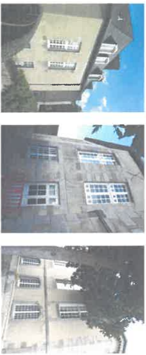
Figure 18 - Façade Sud constituée de la façade F3 du pavillon Sud B et F5 de l'extension Sud-Ouest E.
