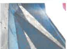
Jonction entre les toitures des 2 pavillons Sud (A2 et B)
