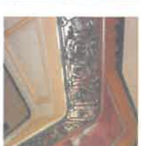
Fissures légères de l'enduit
