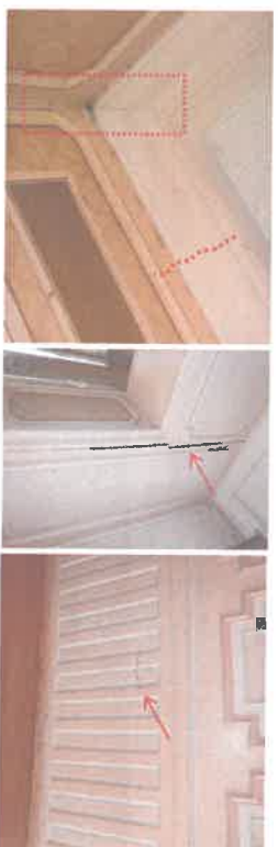
fissures et désassemblages des lambris ou 1er étage (salle de restauration 1)
