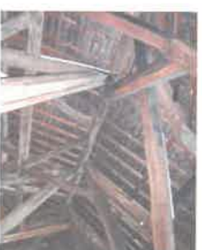
Foilage d'origine portant les fermes de la charpente de la rehausse
