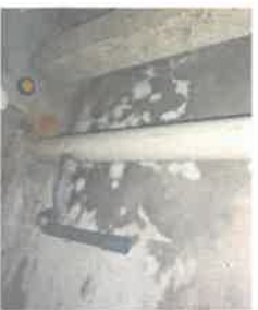
Humidité importante des murs de lambris récent en revêtement intérieur au 1er étage.
