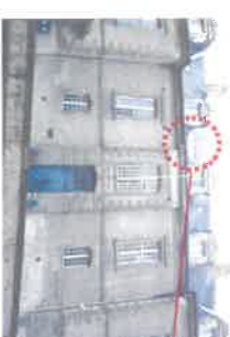
Versants sur rue de la Monnaie de l'hôtel historique : 1 pan de toiture surélevé suite à l'adjonction des charpentes des extensions
