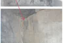
Enduit hydraulique en revêtement intérieur recouvrant une maçonnerie en moellons de granit / schiste, traces d'humidité
