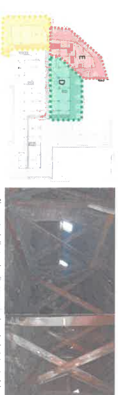
Charpente de l'extension D) composée de croix de Saint-André longitudinales et fermes transversales
