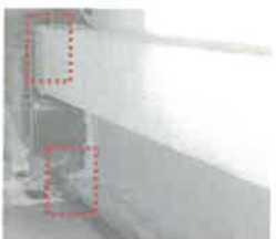
Plancher haut du rez-de-chaussée double en plâtre, poutres maîtresses apparentes reposant sur des corbeaux en granite, coffrés ou noyés dans une maçonnerie – Allée Nord RdC
