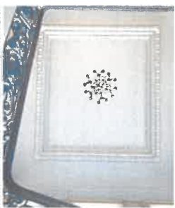
Pignonnel enduit au plâtre doté de décor en stoff
