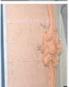
Vestiges de lambris coffrés par les aménagements contemporains
