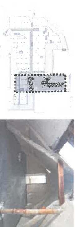
Charpente de l'allée Nord-Ouest C en partie apparente
