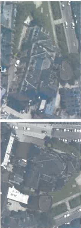
Vue générale Est - rue de la Monnaie
