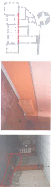
Soubassement (recto-verso) formant refend avec l'extension sud-Ouest E présentant une forte présence d'humidité en RDC
