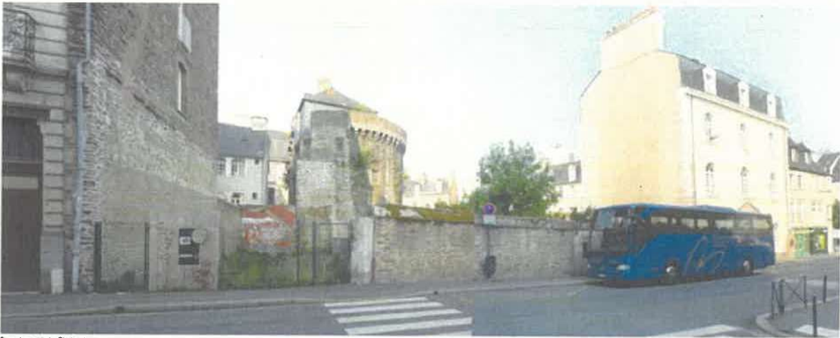
Rue de Juillet : État actuel
