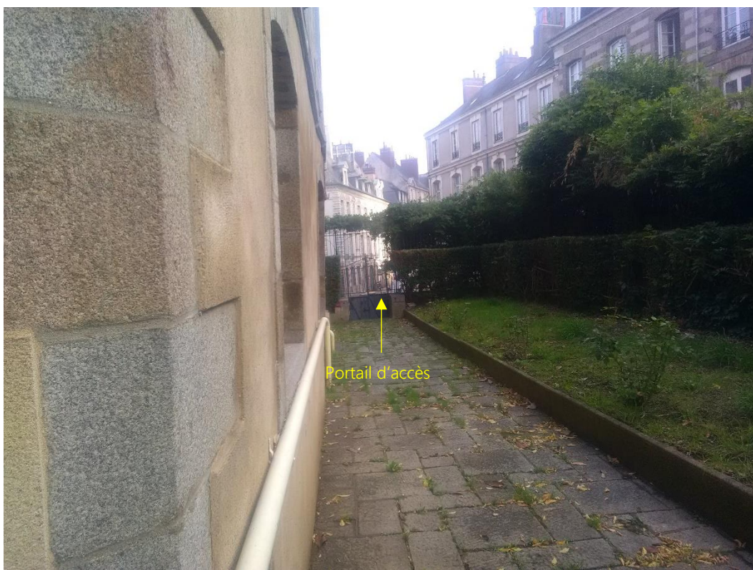
Photographie n° 3 : Vue de l'accès à la terrasse en bordure Est du site et en direction du Nord
