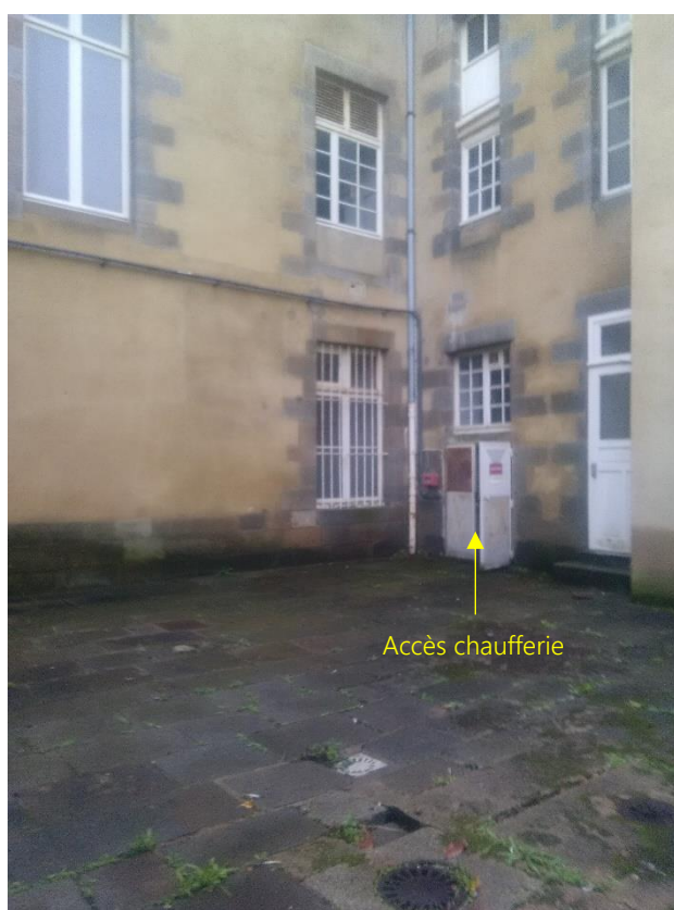
Photographie n° 4 : Vue de l'accès à la chaufferie en partie Ouest du site et en direction du Sud
