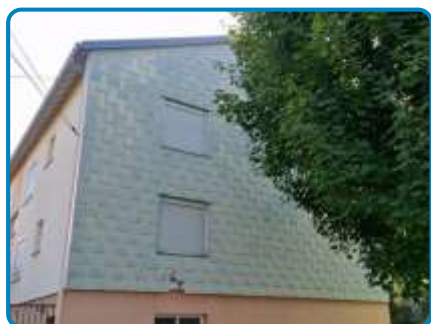
D.O. n° 4 sur Mur Plaques fibres ciment
