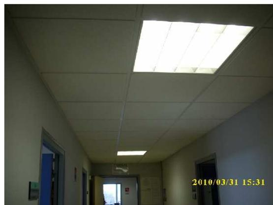
Les locaux sont principalement éclairés par des tubes fluorescents avec ballast ferromagnétique. Les luminaires sont commandés par des interrupteurs dans chaque bureau.
