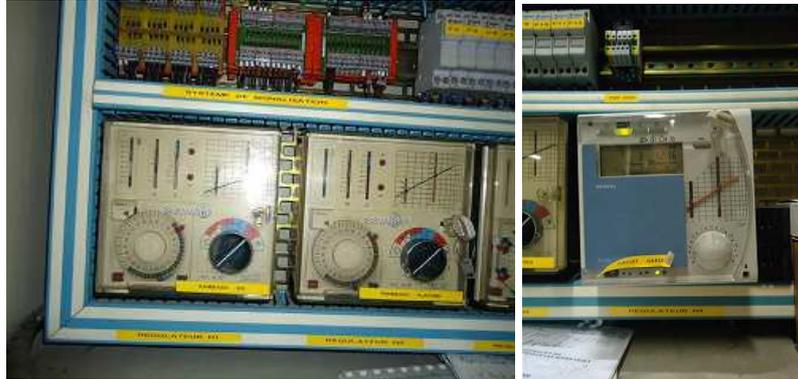
**Figure 7 : Régulateurs de chauffage sur départ réseau**
