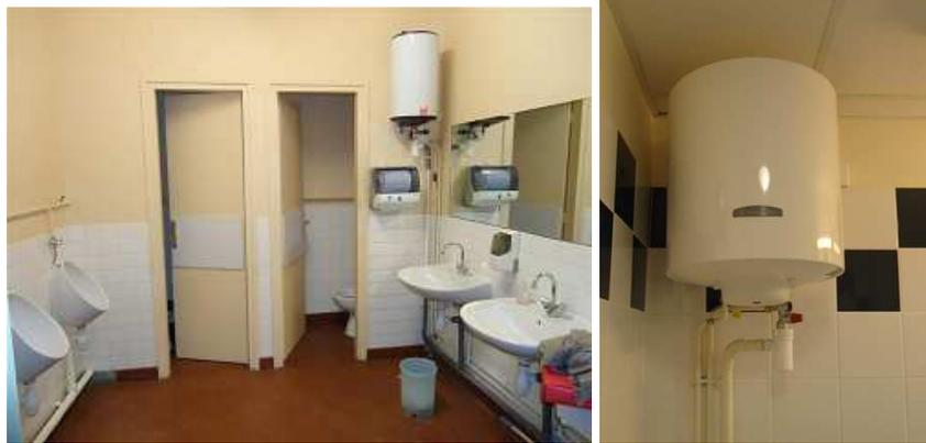
Figure 9 : ballons de stockage ECS dans les sanitaires
