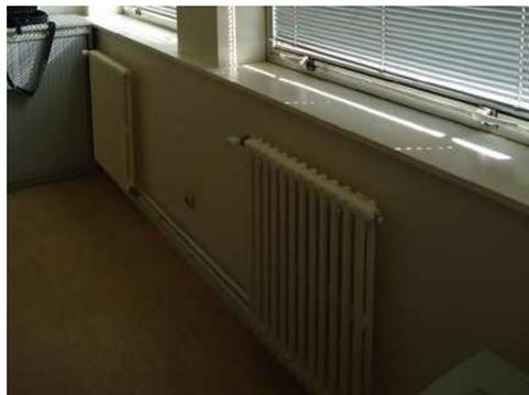
**Figure 8 : Radiateurs fonte, sans têtes thermostatiques**
