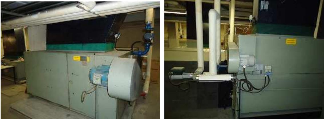
Figure 6 : Aérothermes en chaufferie
