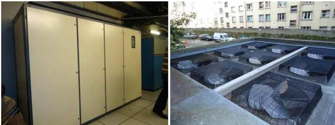
Figure 10 : Armoires de climatisation et aérothermes extérieurs
