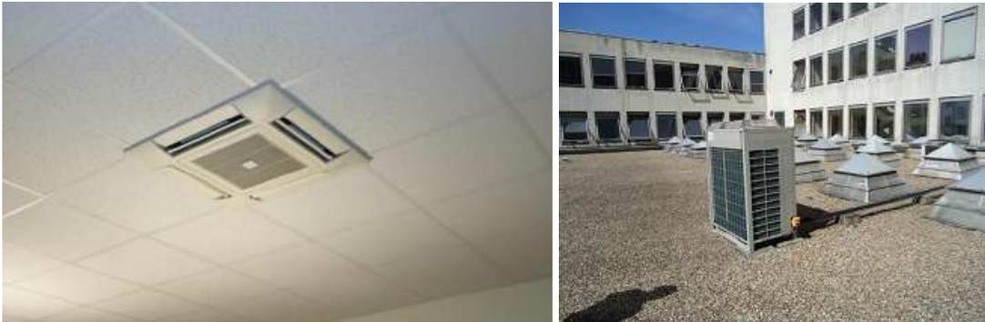
Figure 11 : Climatisation des locaux du R-1
