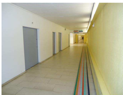
Figure 22 : Eclairage spécifique dans le couloir du rez-de-chaussée du bâtiment A
