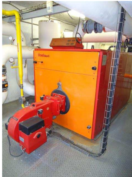
Figure 7 : Production de chauffage principale
