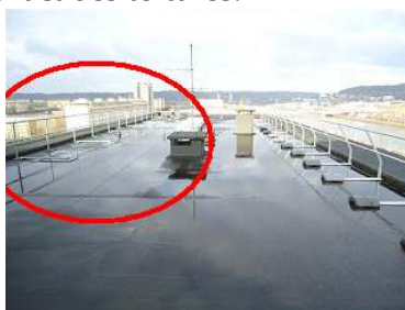
Figure 35 : Garde-corps en toiture-terrasse
