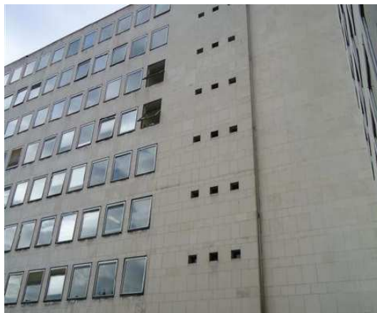
Figure 29 : Fenêtres ouvertes (WC principalement)
