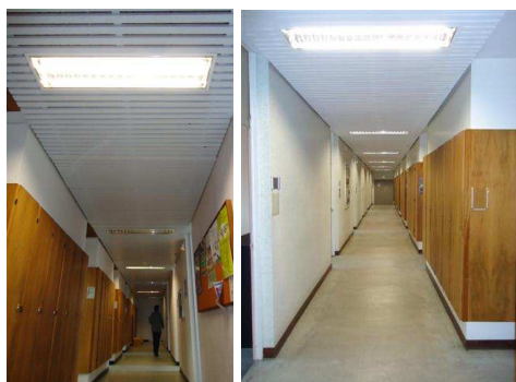
Figure 23 : 50% des tubes fluorescents déconnectés 1 circulation sur 2
