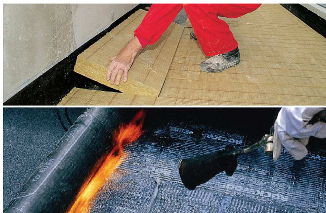
Figure 32 : Mise en place d'un complexe isolant en terrasse
