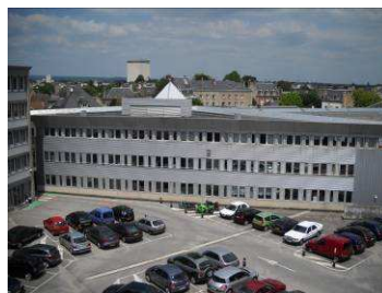
Façade bâtiment E
