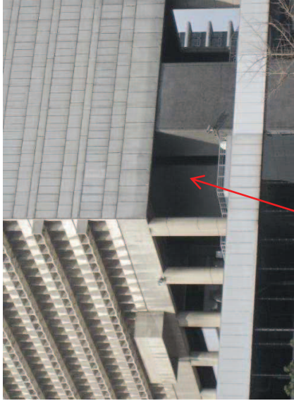
Isolation en sous-face
