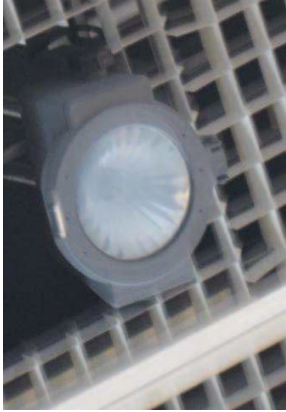
Hall de la Plateforme
