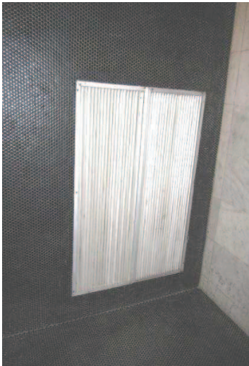
Grille de transfert sanitaire/circulation
