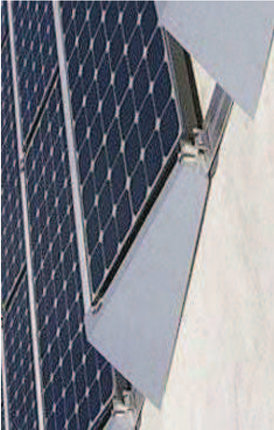
Détail du montage sur équerres
