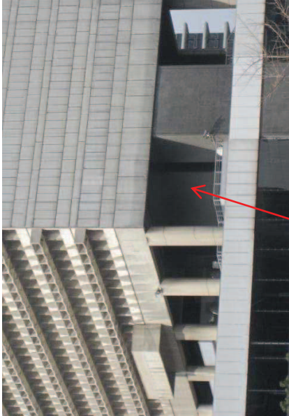
Isolation en sous-face
