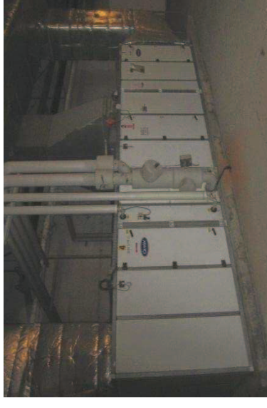
CTA MA4 : en réalité avec caisson de mélange et air extrait, simple gaine
