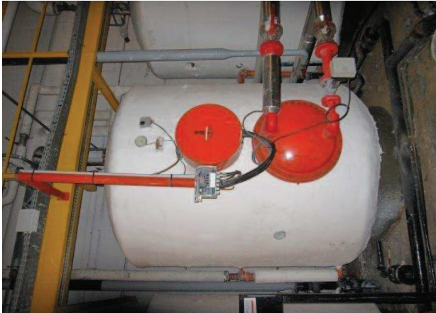
Ballon de stockage 7000l plate-forme
