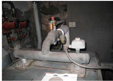
Réseau mal calorifugé
