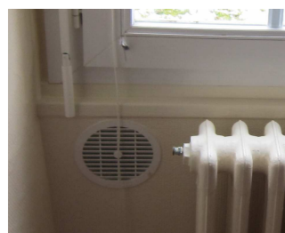
Bouche d'entrée d'air basse sous une menuiserie
