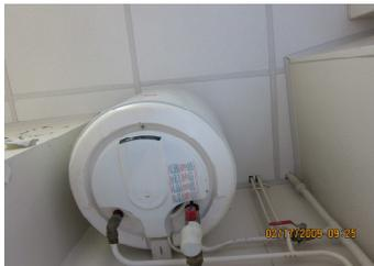
Ballon ECS électrique décentralisé du rez de chaussée
