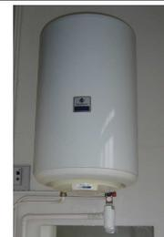
Ballon ECS électrique décentralisé du 2ème étage
