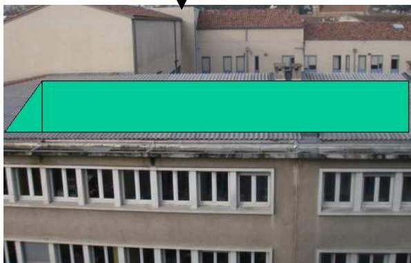
L'installation des capteurs photovoltaïques permet l'implantation de 250 m<sup>2</sup> de toiture (120 W/m<sup>2</sup> : ratio de puissance en fonction de la surface de toiture disponible ADEME) soit 28,8 kW.
