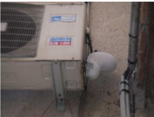
L'état du calorifuge est critique pour la PAC du réseau informatique. On observe la présence de glace à la sortie de l'évaporateur. Calorifuger les canalisations dans leur totalité pourrait remédier au problème. Il est important de contrôler s'il n'y a pas de fuites dans le circuit.
