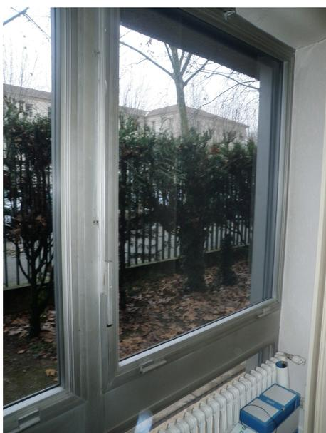
Il existe une unique fenêtre en aluminium simple vitrage sans rupteur de ponts thermiques de 4 mm d'épaisseur au RdC. Elle est également posée en nu intérieur.
