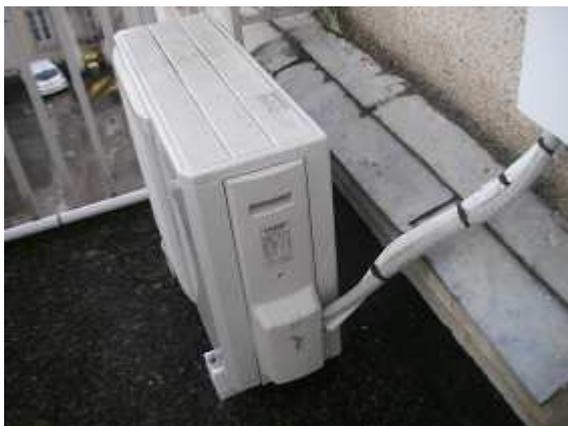
Le calorifuge au niveau des canalisations de froid, qu'elles soient au niveau de la production ou bien de la distribution, sont correctes.
