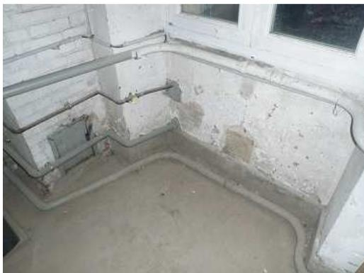
**ATTENTION :** en chaufferie le départ du réseau n'est pas calorifuger, soit environ 20 m.
