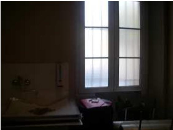
L'ensemble des bâtiments dispose de menuiseries PVC et du double vitrage 4 x 12 x 4. On observe que les vitrages sont des vitres claires sans protection solaire de type couche basse émissivité ou casquette solaire.
