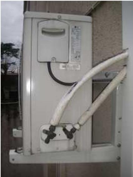
Le calorifuge au niveau des canalisations de froid, qu'elles soient au niveau de la production ou bien de la distribution, sont correctes.
