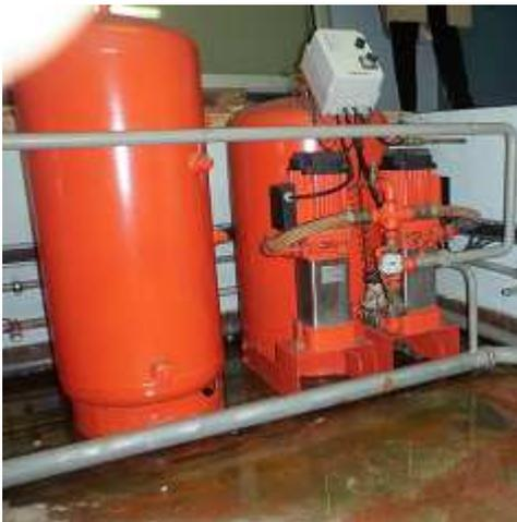
Voici une photo des sursesseurs permettant l'alimentation des bâtiments éloignés de la production. Pour exemple, on remarque que pour le bâtiment A (le plus éloigné de la chaufferie), nous avons un écart (une perte) de 26 °C entre la chaufferie et la sous station du bâtiment :
