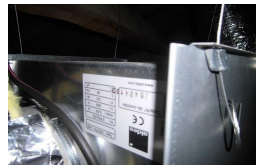
Caisson d'extraction à variateur de vitesse : Très performant
