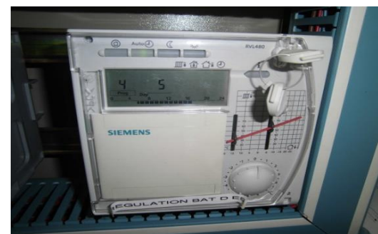
Détail d'un régulateur correctement programmé
