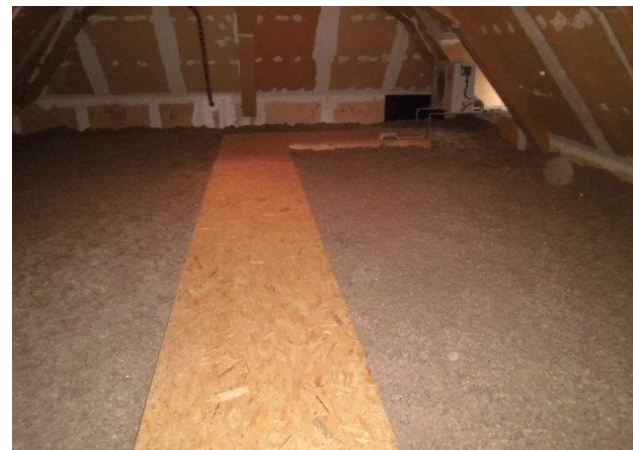
Toiture isolée avec 30 cm LdV et cheminement - Bât A
