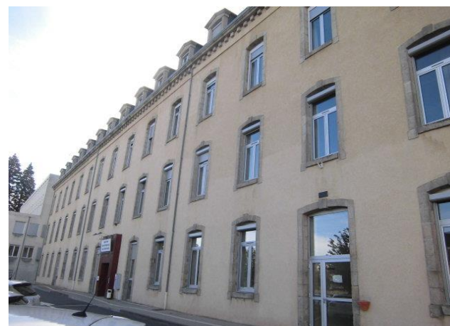
Murs non isolés du bâtiment D
