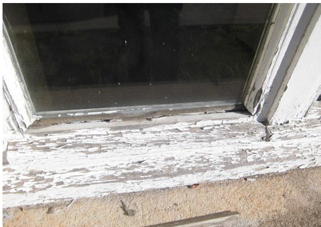
Menuiseries bois - bâtiment B
