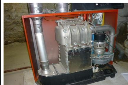
Détails de la chaudière à condensation
