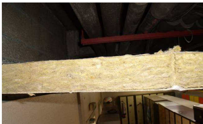
Isolation du plancher haut (vestiaires – sous sol donnant sur l'extérieur)
