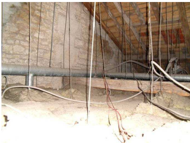
Isolation en combles perdus
