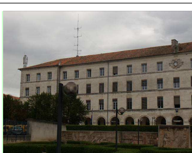
Secteur POLICE (Façade OUEST)
